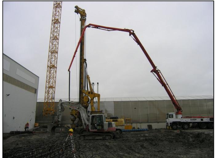
Bild 1: Tiefbohrungen Faulturmfundament
